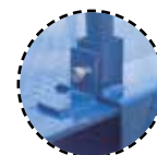
Fijación Perfil HEB y Barandilla lateral
